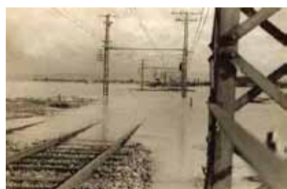
昭和28年の13号台風で小倉、横島、伊勢田地区が冠水、長いところは80日も水が引かなかった。中央に見えるのは近鉄小倉駅(ホームの上1m冠水)
